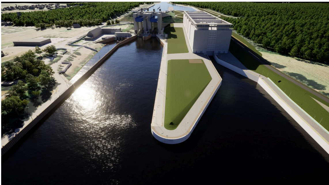
Bild : © INGE Schleuse Lüneburg
